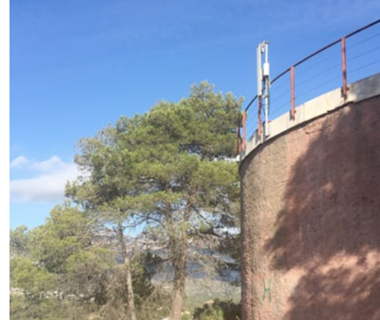
Dipòsit d'aigua de Vacarisses. Foto: David Martín.
