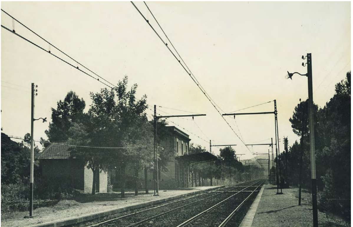
Vista general de l'estació de Vacarisses a principis dels anys 50. Fotografia de l'arxiu del Museu del Ferrocarril de Catalunya.
