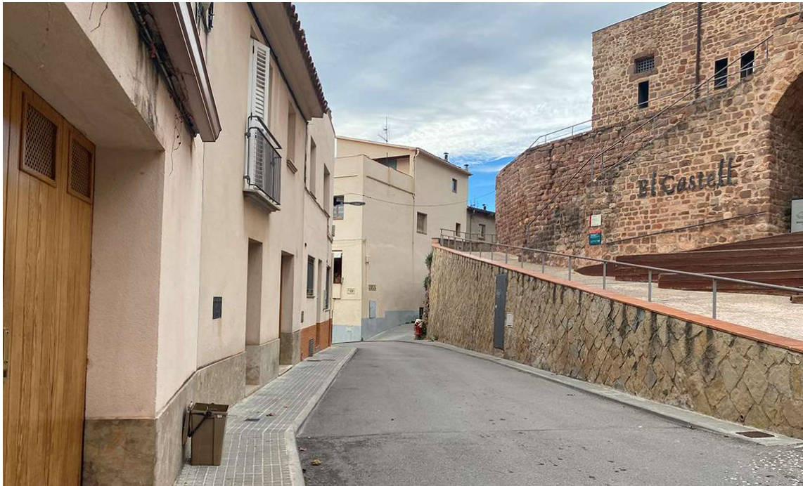
Adaptació de l'arquitectura als desnivells topogràfics i predomini del ple sobre el buit. Homogeneïtat en les tonalitats dels acabats de façana. Font. Pròpia.
