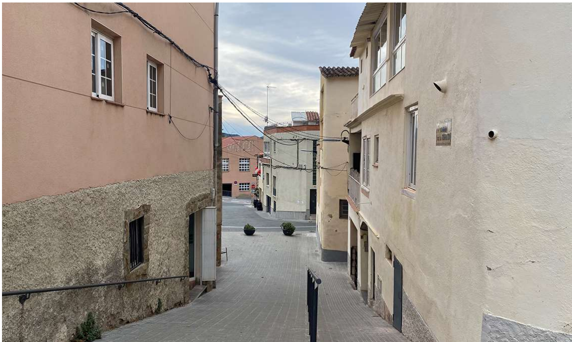
Escala humana i sensació de domesticitat. Adaptació de l'arquitectura als desnivells topogràfics. Prioritat del vianant respecte del vehicle privat. Font. Pròpia.
