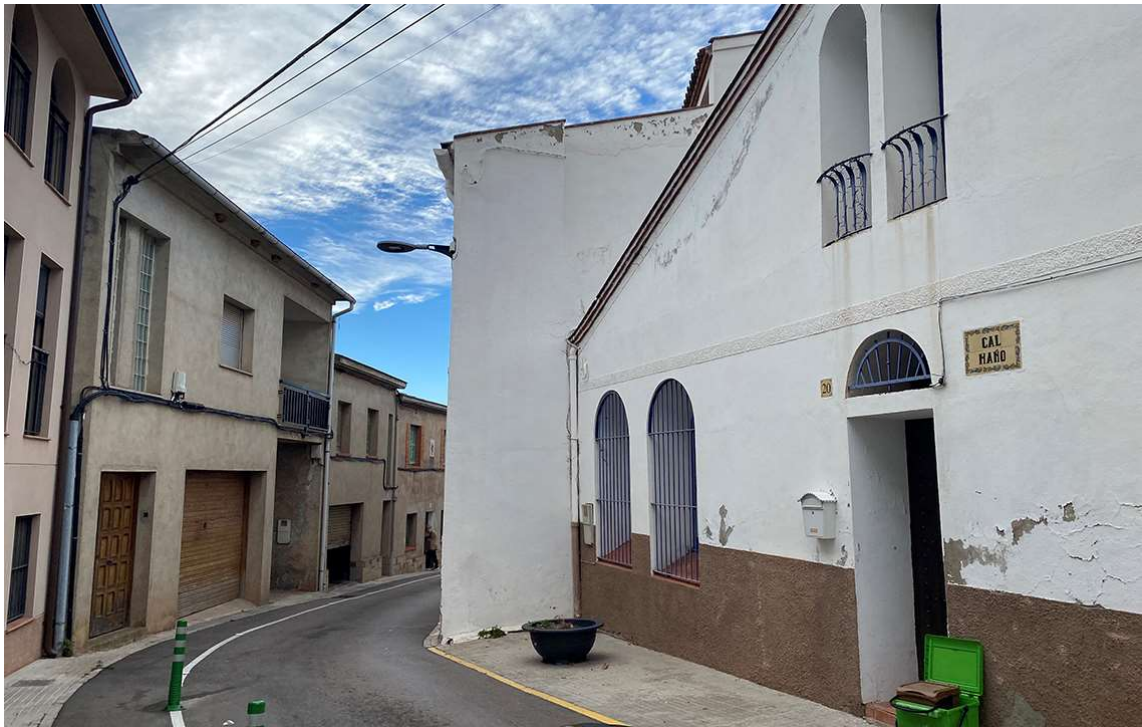
Adaptació de l'arquitectura als desnivells topogràfics, manteniment de les alineacions a carrer. Ràfecs de coberta integrats als canvis de nivell. Font. Pròpia.
